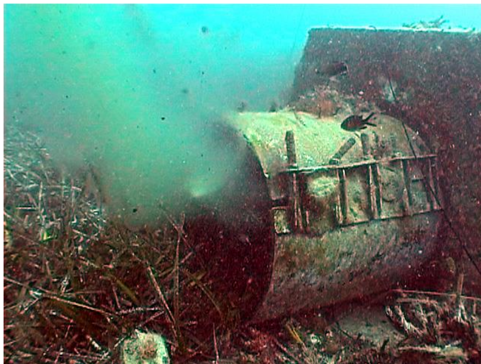
Fotografía 15. Cota -12 m. Rotura del emisario
