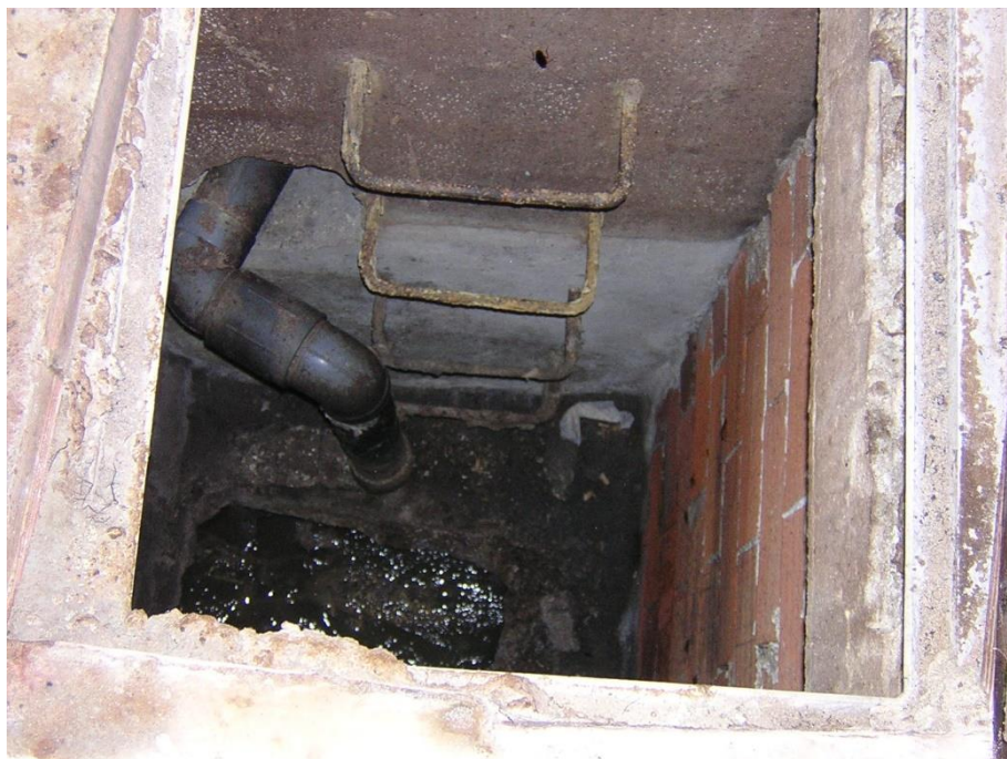
Fotografía 12. Arqueta de salida del aliviadero de emergencia d'Es Pujols
