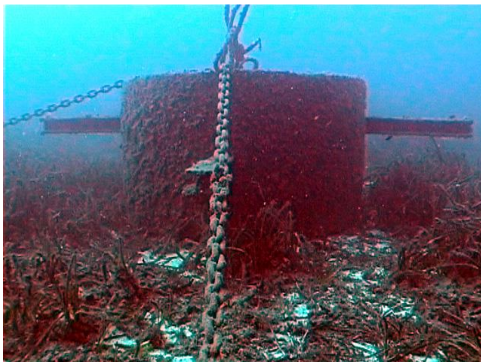
Fotografía 24. Cota -21 m. Bloque de protección unido con caden
