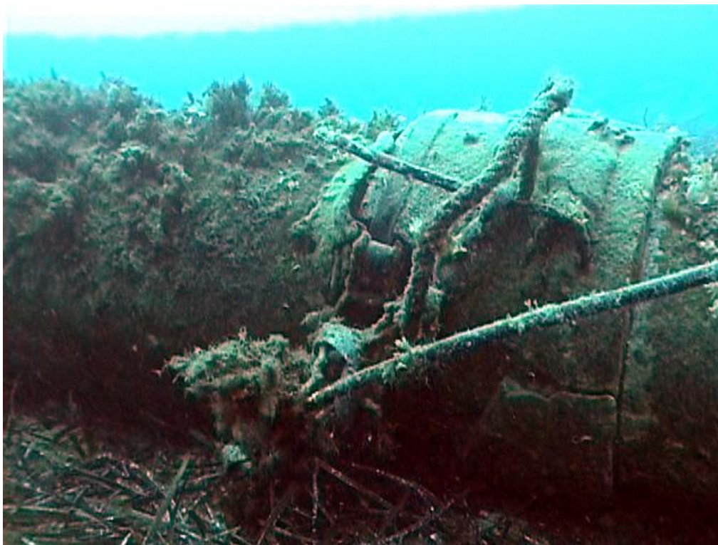
Fotografía 18. Cota -15 m. Brida de fibrocemento rota y mal reparada
