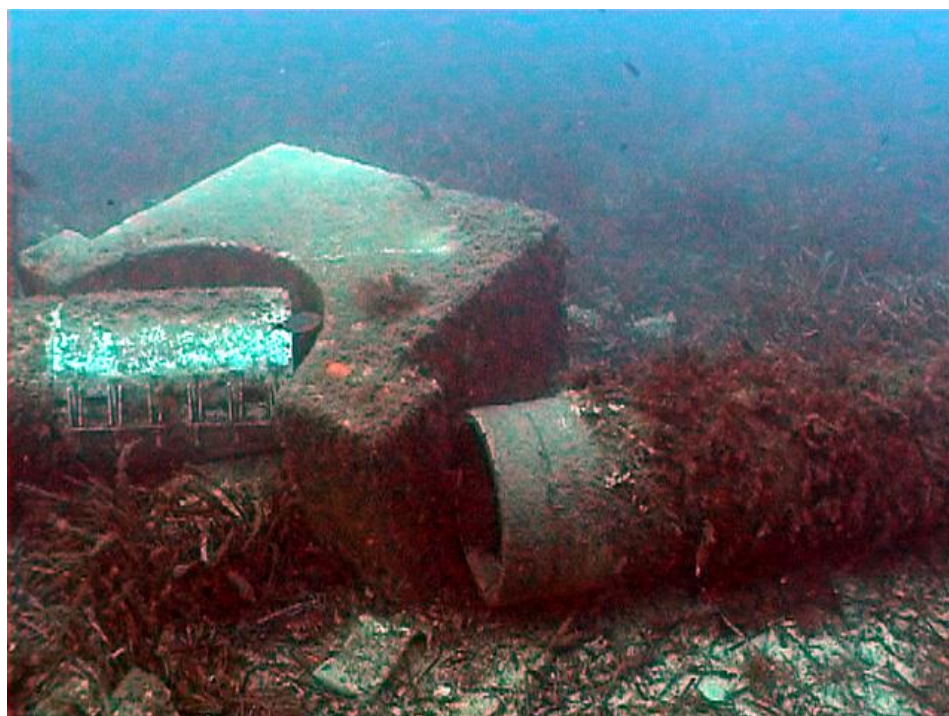
Fotografía 16. Zona de rotura con bloques de gran tamaño y junta de reparación
