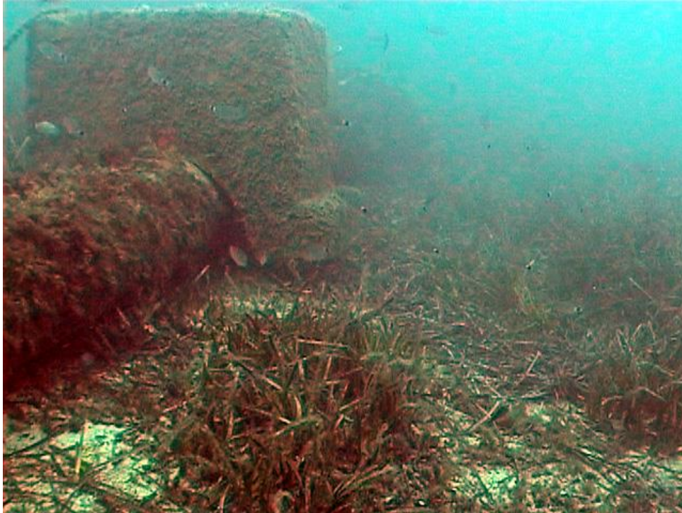
Fotografía 17. Bloques de gran tamaño sin apoyo sobre el fondo marino
